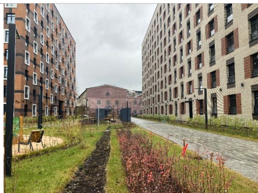
Фотография 3.4. Прилегающая территория
