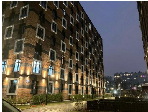
Фотография 3.6 Фасад жилого дома
