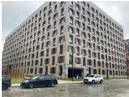
Фотография 3.2. Фасад жилого дома
