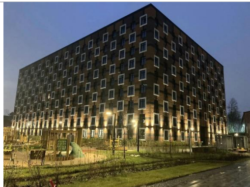
Фотография 3.5. Фасад жилого дома
