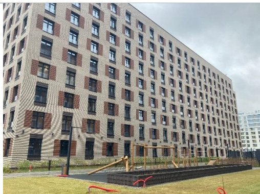
Фотография 3.1. Фасад жилого дома
